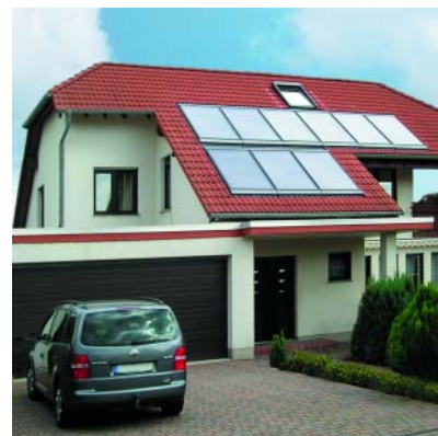
Systèmes solaires WTS-F1 en intégration de toiture
