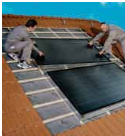
Verlegen der Solarflächen ist lernbar.
