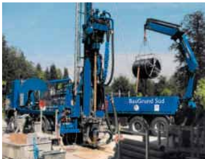
Zertifizierte Bohrfirmen arbeiten zuverlässig.
