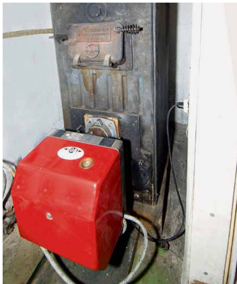
Der Zent Heizkessel aus Klosters. Ca. Jahrgang 1910 (Kohle) und ab ca. 1930 mit Ölbetrieb.
