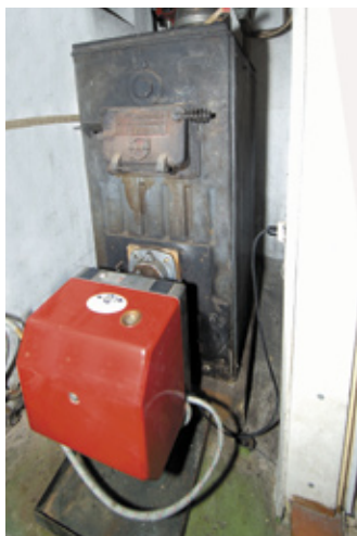
Der Zent-Heizkessel in Klosters: ca. Jahrgang 1910 (Kohle) und ab ca. 1930 mit Ölbetrieb.
