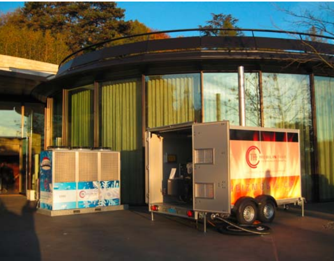
Mobile Kühl- und Heizanlagen der Firma Mobil in Time AG.
