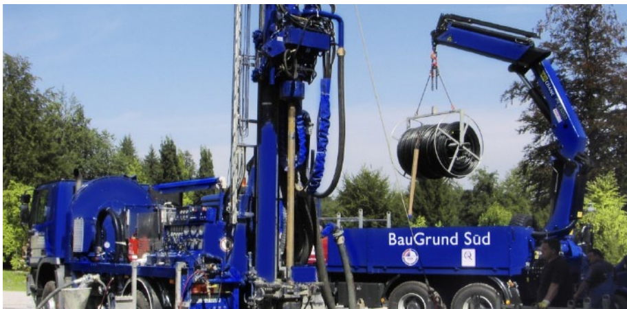
Erdsondenbohrung der Baugrund Süd. (Bilder: Weishaupt)
