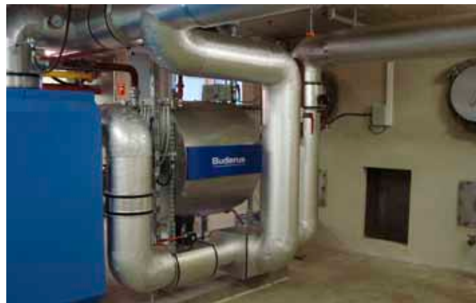
Die Economiser hinter den Kesseln versorgen den 60-°C-Heizkreis und helfen merklich mit, Energie zu sparen.
