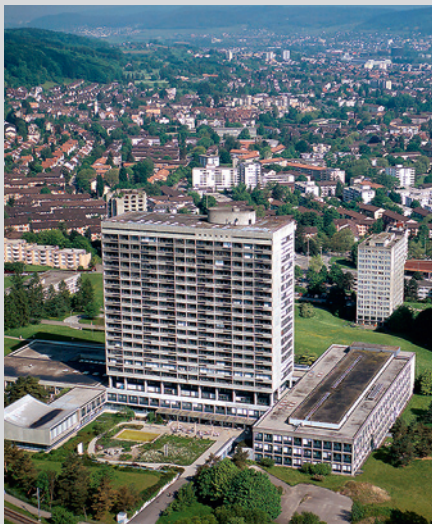
Das Triemli-Spital Zürich hat einen sehr hohen Bedarf an Warmwasser und Heisswasser bei rund 567 Patientenbetten.
