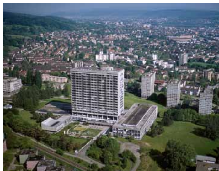
Das Triemli-Spital Zürich hat einen sehr hohen (abgesicherten) Bedarf von Warmwasser und Heisswasser bei rund 567 Patientenbetten.
