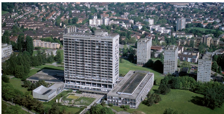
Das Triemli-Spital Zürich hat einen sehr hohen (abgesicherten) Bedarf von Warmwasser und Heisswasser bei rund 567 Patientenbetten.
