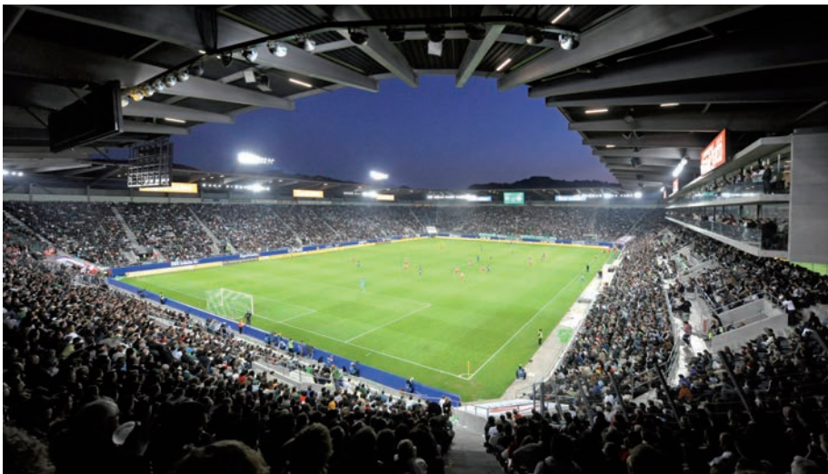
AFG Arena – Rasenheizung des offenen Fussballfeldes in Einklang mit den Bedürfnissen des Einkaufs- und Unterhaltungscen- ters: Wärmeerzeugung mit fossilen Brennstoffen mit Weishaupt Zweistoffbrenner multiflam RGL 50/1-B 3LN und Gasbrenner multiflam G7/1-D LN.
