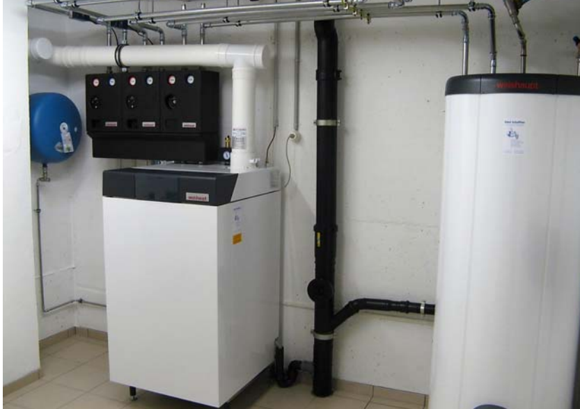
Wird auf diesen Produkten bald auch in der Schweiz eine Energieetikette aufgeklebt werden müssen? Brennwertkessel in Kombination mit einem Wassererwärmer. (Foto: Härrli / Weishaupt)
