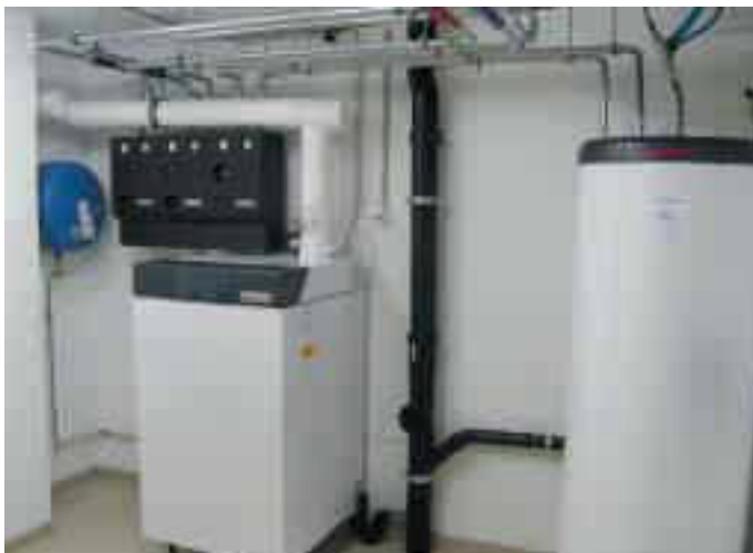
Wird auf diesen Produkten bald auch in der Schweiz eine Energieetikette aufgeklebt werden müssen? Brennwertkessel in Kombination mit einem Wassererwärmer.
