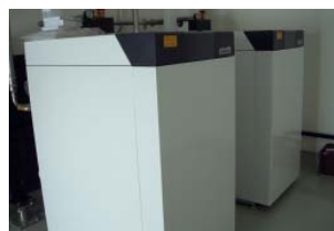
Die beiden Standkessel in der DRM-Station Domat-Ems.
