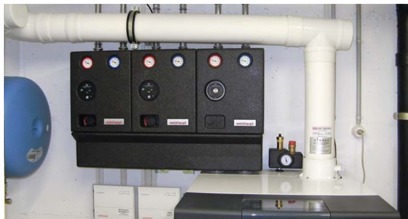
Vormontierte Anschlussgruppen ermöglichen eine übersichtliche Einbindung der neuen Anlage in das bestehende Heizsystem. Die Verbrennungsluft und die Abgase werden über das Kunststoffdoppelrohr geführt.
