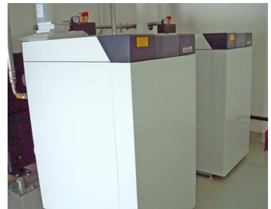
Die beiden Weishaupt-Standkessel in Domat/Ems.
