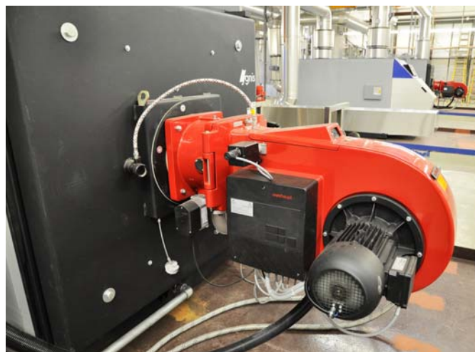
Es wurden wiederum drei Kessel eingebaut, zwei Kessel mit Zweistoffbrenner und ein Kessel nur für Gas.
