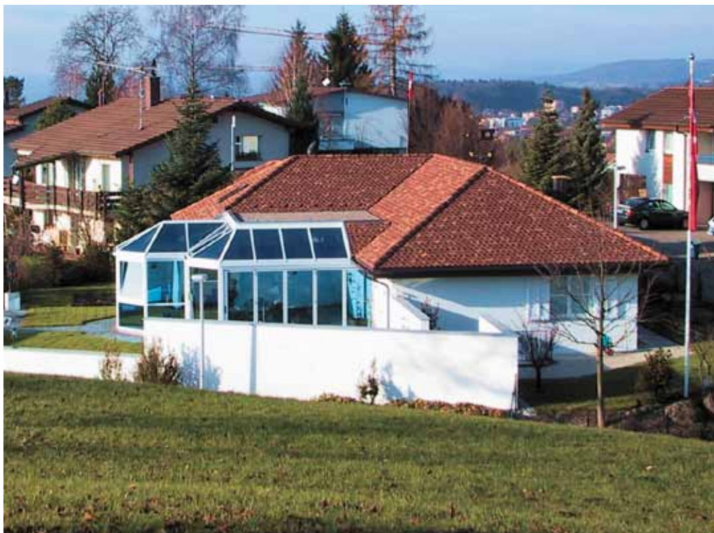
Ein neuer Ölkondensationskessel versorgt das Landhaus und den Wintergarten mit Wärme.
