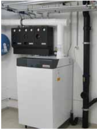
Der Einbau eines Thermo Condens von Weishaupt erwies sich als die zweckmässigste Sanierungsvariante. (Foto Härrli)
