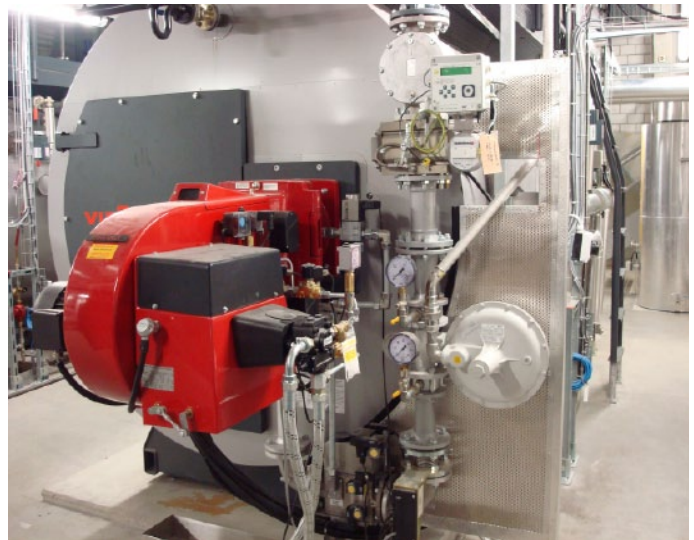
Blick auf den 9-MW-Weishaupt-Zweistoffbrenner für das ETH-Energiernetz. Weishaupt Monarch Zweistoffbrenner an einem der Dampfkessel.
