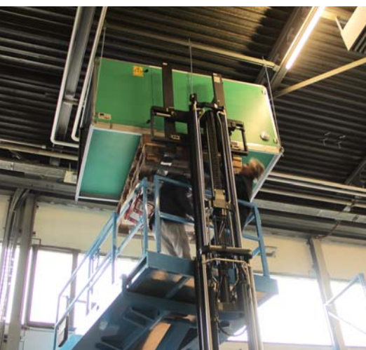
Installation eines Monoblocs für die neue Hallenheizung.
