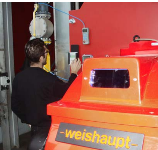
Inbetriebnahme des neuen Weishaupt-Brenners.
