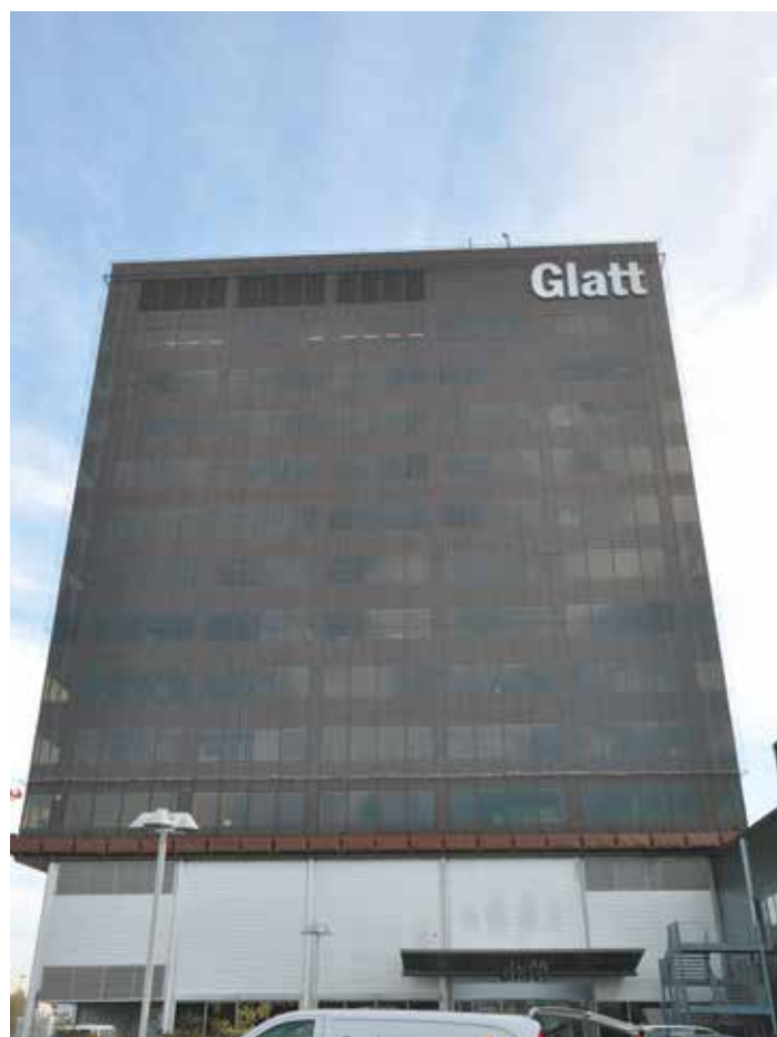
2012 besuchten 8.67 Millionen Menschen das Einkaufszentrum Glatt. Dass sie sich wohl fühlten, sorgte eine qualitativ hoch stehende Haustechnik.
