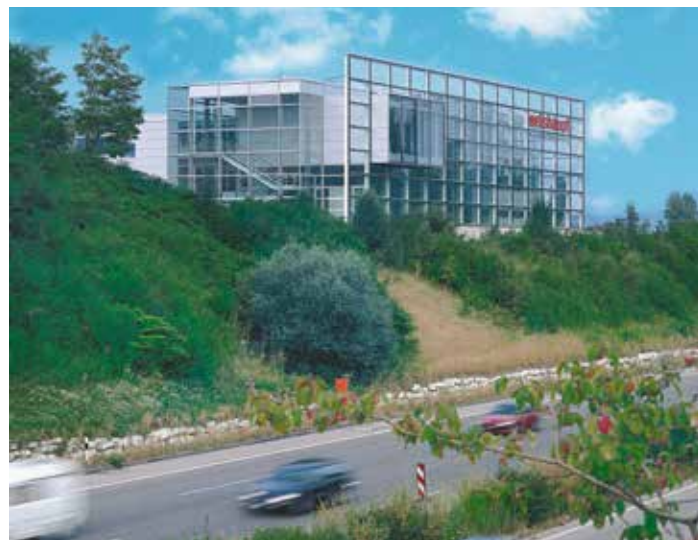
Das Verwaltungs- und Schulungszentrum in Geroldswil – direkt an der Autobahn – ist ein Kompetenzzentrum zur Aus- und Weiterbildung von Fachleuten. (Bilder: zVg)
