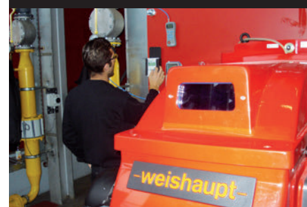
Der alte Kessel wird aus dem Gebäude manövriert (oben). Wenig später war der neue bereits platziert.
