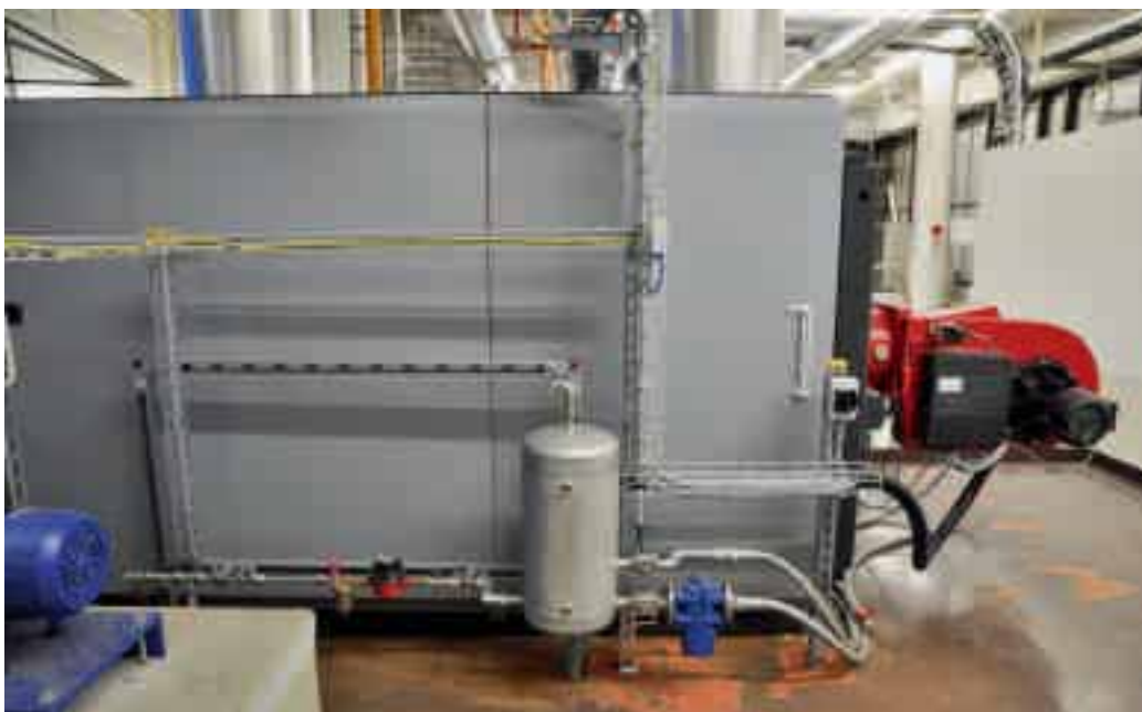
Es wurden erneut drei Kessel eingebaut, zwei Kessel mit Zweistoffbrenner und ein Kessel nur für Gas.
