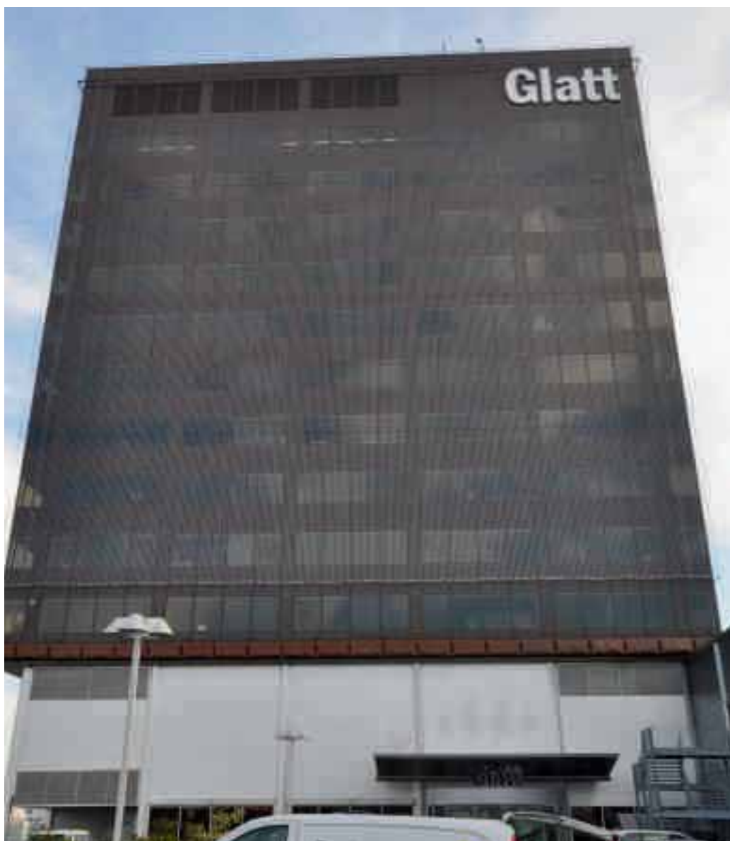
2012 besuchten 8,67 Millionen Menschen das Einkaufszentrum Glatt. Dass sie sich wohl fühlten, dafür sorgt eine qualitativ hochstehende Haustechnik.
