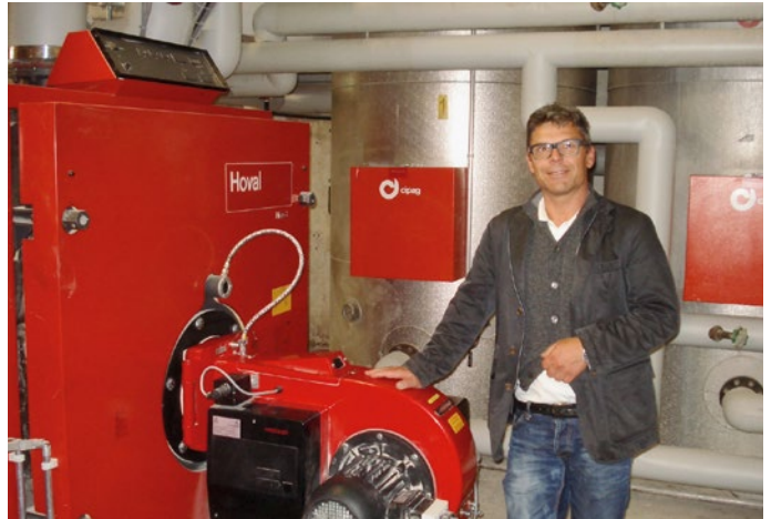
«Die Erstellung dieser Anlage hat uns alle mächtig gefordert», meint Remo Kunz, Inhaber der Frei Sanitär AG in Davos.
