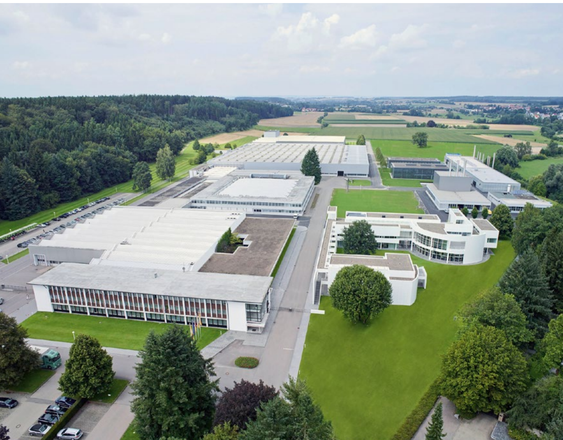
Das Weishaupt-Werksgelände in Schwendi mit dem neuen, erweiterten Forschungs- und Entwicklungszentrum (rechts oben).
