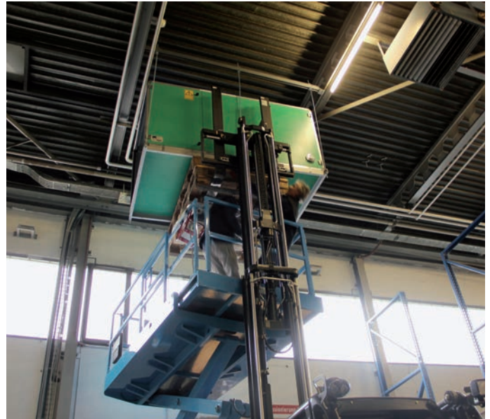
Installation eines Monoblocs für die neue Hallenlüftung.
