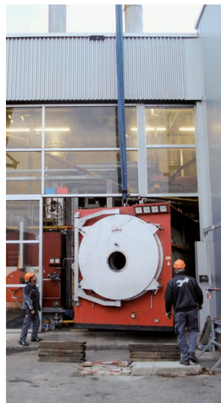
Man sieht, wie eng das war: Ausbringen des alten Weber-Kessels aus der Rivella-Heizzentrale.
