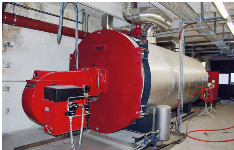
Der Giga-3-(5000-)Kessel von Hoval mit 5 MW Leistung. (Bild: Hoval AG)
