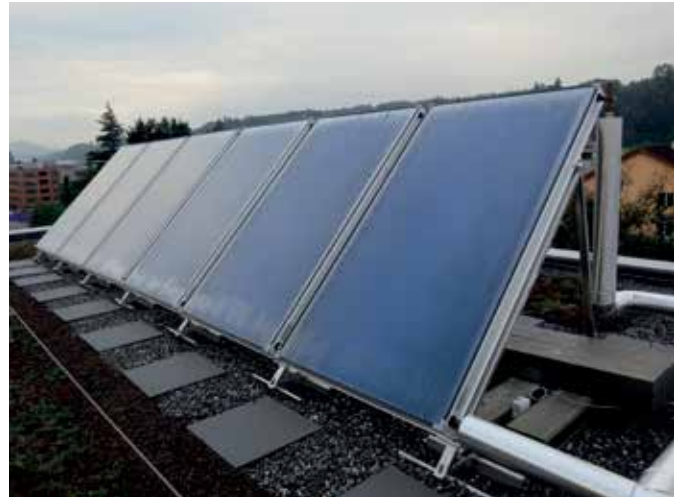
Mit vormontierten Ständern aus Aluminium werden die Kollektoren in einem idealen Winkel zur Sonneneinstrahlung ausgerichtet.
