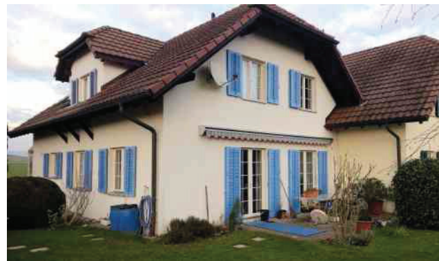
Das neue Öl-Brennwertsystem Weishaupt Thermo Unit versorgt das Einfamilienhaus der Familie Rüeegg mit Wärme. (Fotos: zVg)
