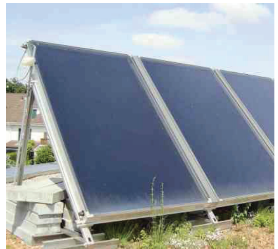
Die Solarkollektoren WTS-F2 sind speziell für die Aufdach- und Flachdachmontage konzipiert.
