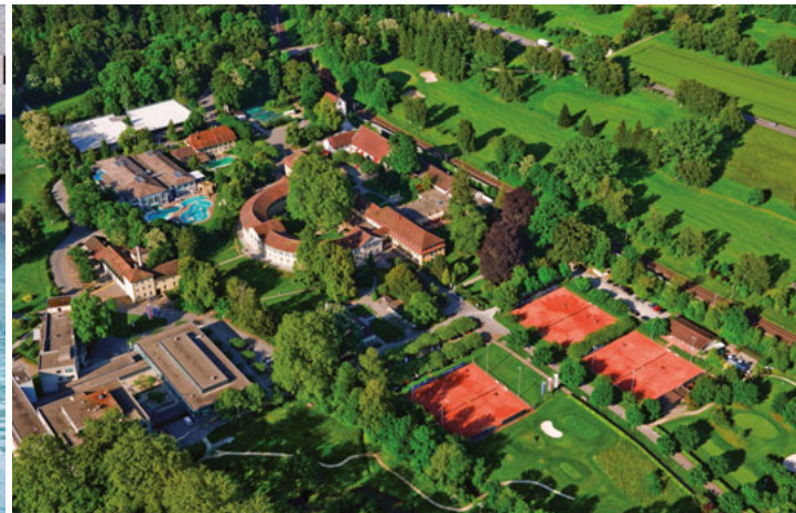
Luftaufnahme von Bad Schinznach: ein riesiges Areal. Das Thermi ist noch alt, ebenso die Heizzentrale (denkmalgeschütztes Hochkamin).
