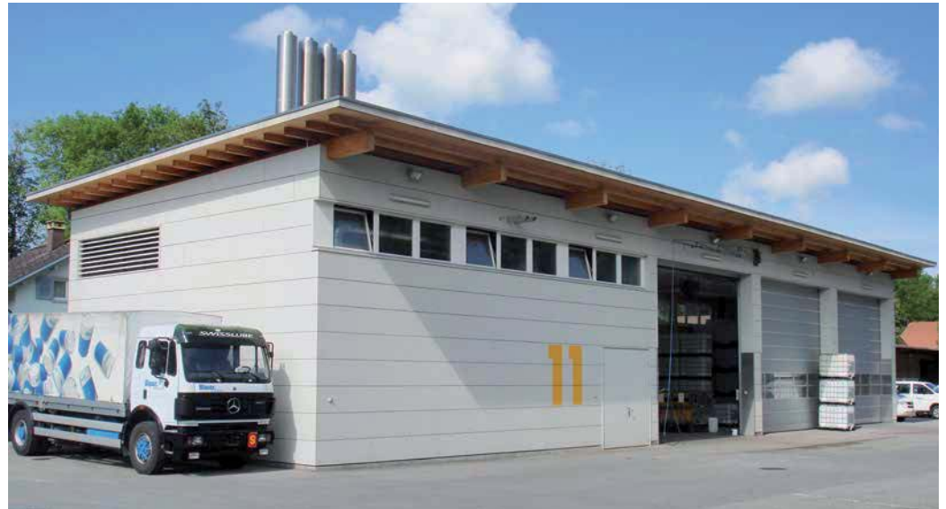
Die Heizzentrale mit ihren vier Kaminen.
