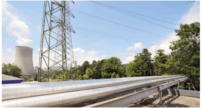
Das Kernkraftwerk Gösgen liefert über eine Fernleitung von 1,8 km Länge Dampf für die Papierfabrik. Foto: AKW Gösgen
