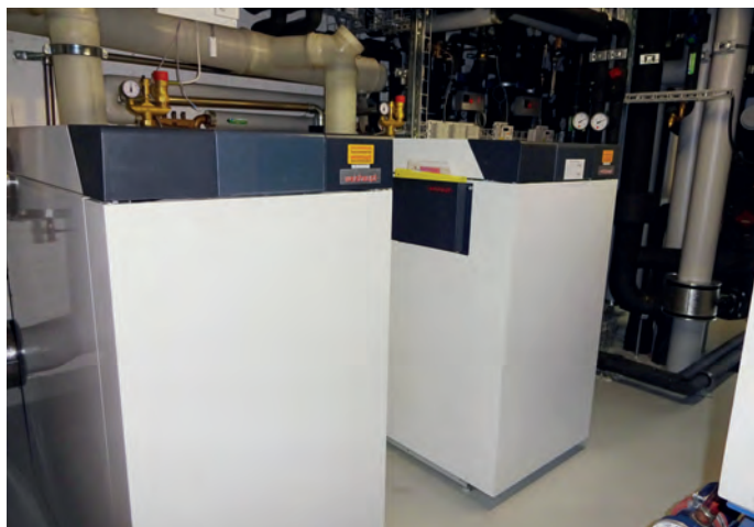
Zwei Gas-Brennwertkessel WTC-GB von Weishaupt mit je 200 kW im 4. OG.
