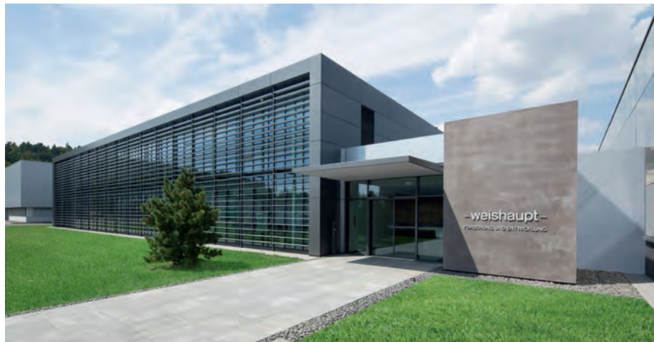
Rund 15 Millionen Euro hat die Max Weishaupt GmbH in die Neugestaltung und Erweiterung ihres Forschungs- und Entwicklungszentrums in Schwendi investiert. (Bild: Weishaupt)
