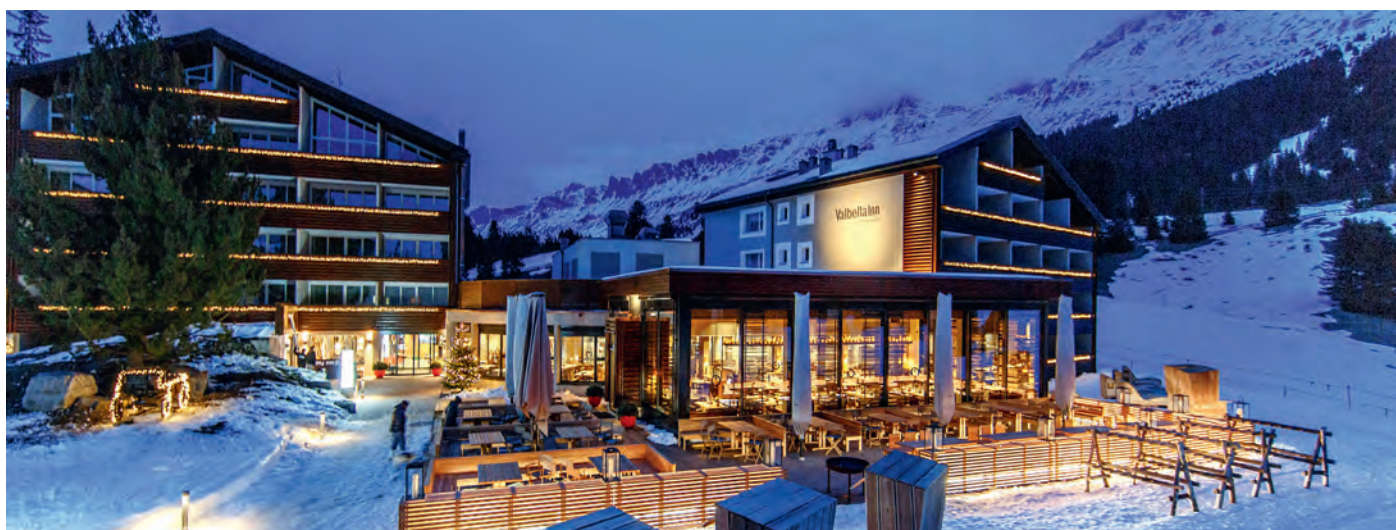
Teilansicht des Valbella Inn Resort. Über eine Fernleitung werden diese beiden Häuser von der zentralen Ölheizung mit Wärme versorgt. (Bild: Urs Homberger)
