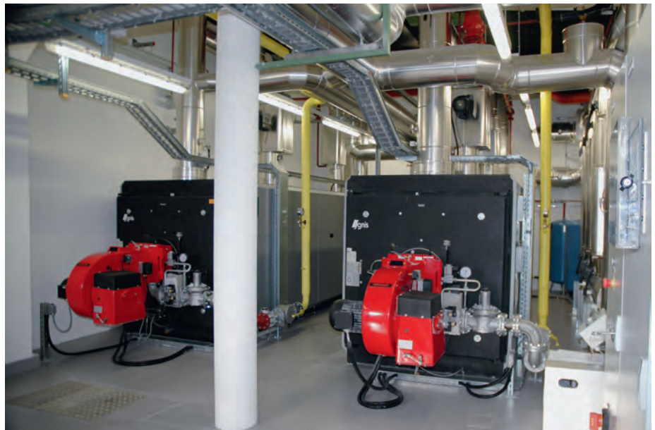
Die Weishaupt-Erdgas-Brenner G 50 modulieren im Verhältnis 1:3.
