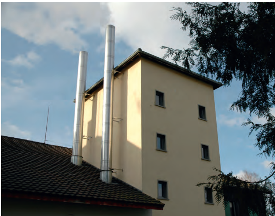
Die neue Kaminanlage. (Bilder: Jasmin Al-Timimi)
