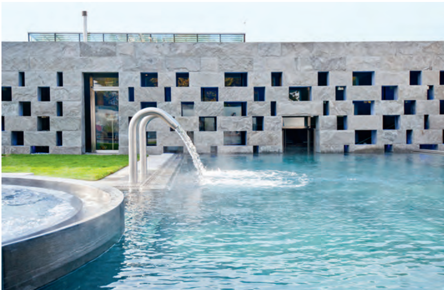
Das neue Thermi Spa mit Becken.
