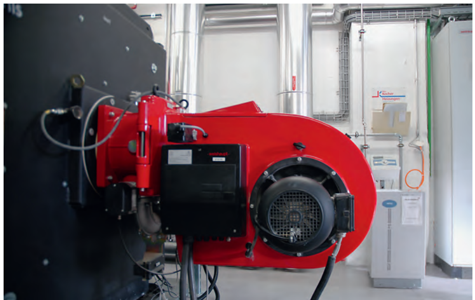
Die Weishaupt-Erdgas-Brenner G 50 modulieren im Verhältnis 1:3.
