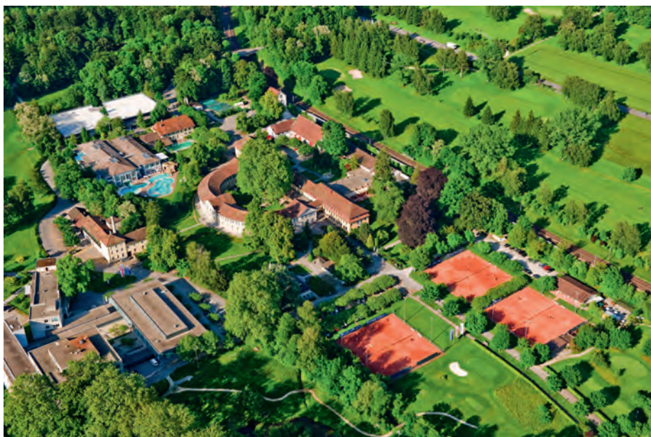
Luftaufnahme von Bad Schinznach: Ein riesiges Areal. Das Thermi ist noch alt, ebenso die Heizzentrale mit dem denkmalgeschützten Hochkamin. (Bild: Bad Schinznach AG)
