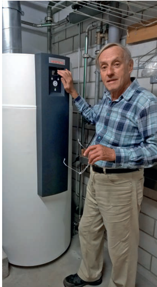
Die Weishaupt Trinkwasser-Wärmepumpe WWP T 290, mit 290 Liter Speichereinhalt.
