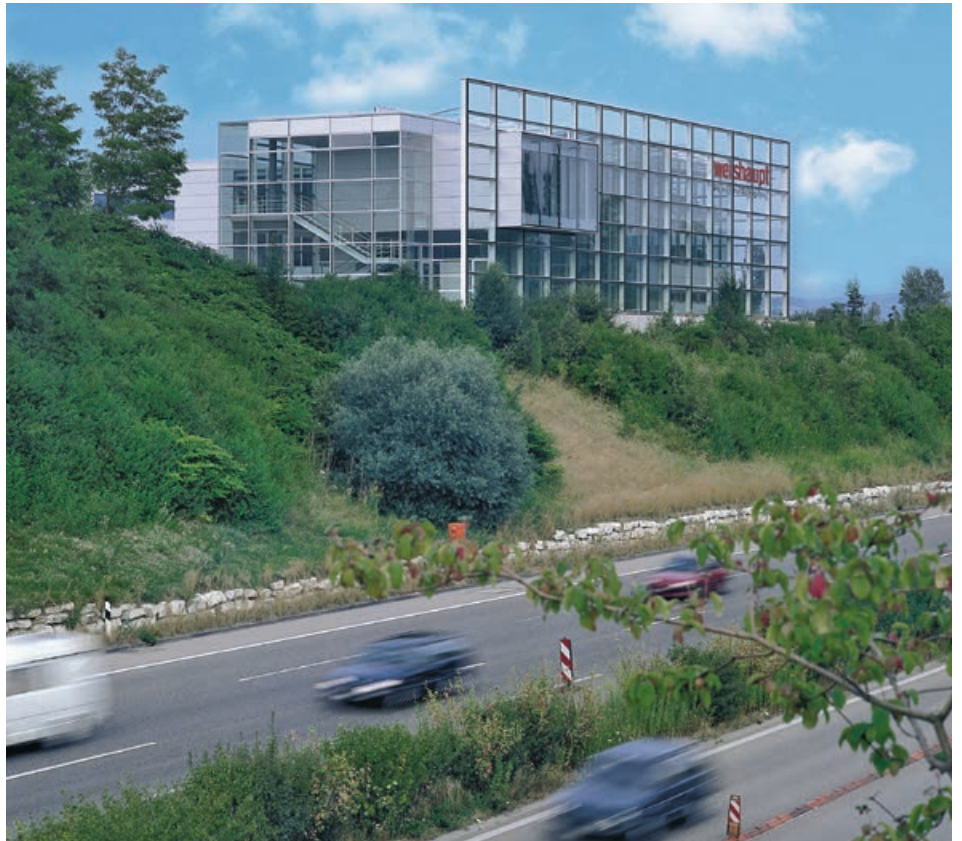
Das Verwaltungs- und Schulungszentrum in Geroldswil – direkt an der Autobahn – ist ein Kompetenzzentrum zur Aus- und Weiterbildung von Fachleuten. (Bilder: zVg)
