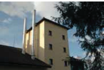
Die neue Kaminanlage
