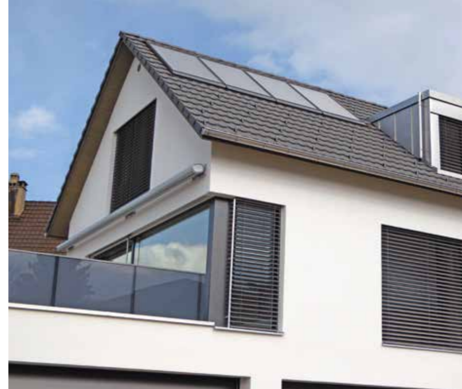
Neubau mit Solarkollektoren unterhalb des Firsts auf der Ostseite des Dachs.
