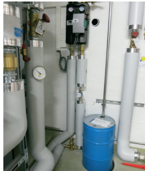
Die Solarstation mit Auffanggefäss sorgt für Sicherheit bei Überdruck.
