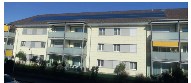
Solaranlage gewinnt die Wärme für den Speicher des Heizwassers.
