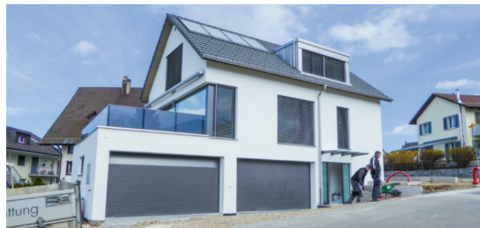
Neubau der Familie Nauer in Oberwil-Lieli, AG, mit Solarkollektoren unterhalb des Firsts auf der Ostseite des Dachs. (Antonio Suárez ®)
