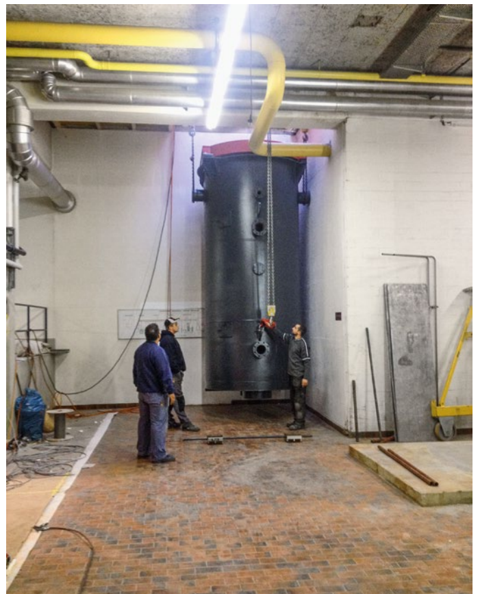
Einbringung eines der Hoval-Warmwasserkessel ohne Isolierung, von oben, durch die kleine Lücke ganz hinten.
