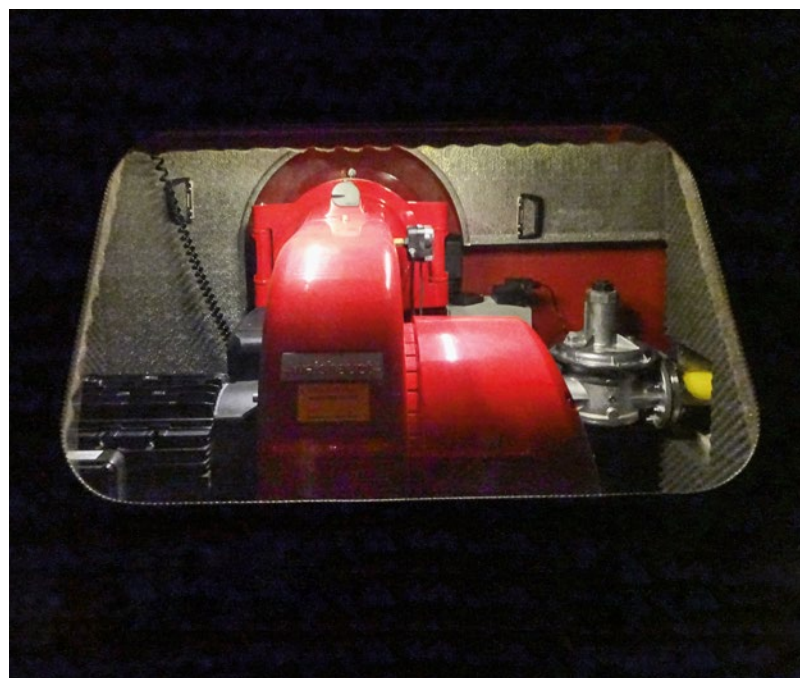
Licht-Show – der Weishaupt-Brenner unter dem Fenster der Schalldämmhaube.
