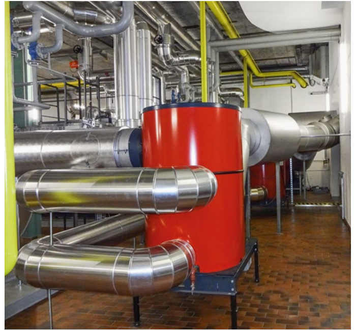
Die Hoval-AF-Thermokondensatoren hinter den Kesseln nutzen den Brennwert des Gases.
