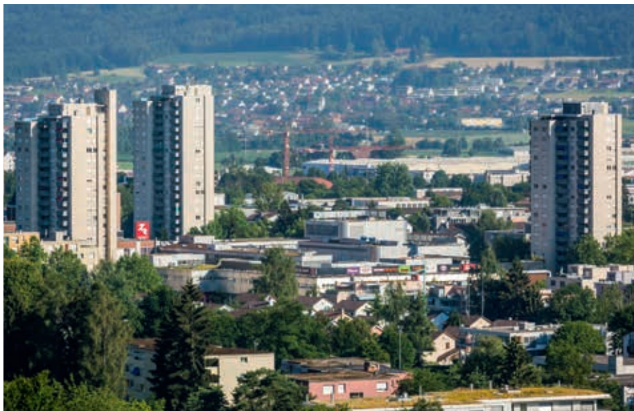
Die Energiezentrale des EKZ (Bildmitte) beliefert auch die drei Wohnhochhäuser mit Wärme.
