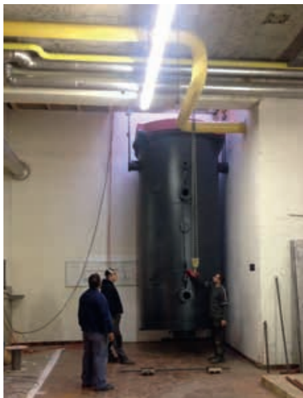
Einbringung eines der Hoval-Warmwasserkessel ohne Isolierung, von oben, durch die kleine Lücke ganz hinten.
