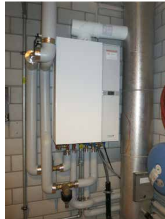
Die platzsparende wandhängende Gas-Brennwertanlage dient als Ausweichoption.
