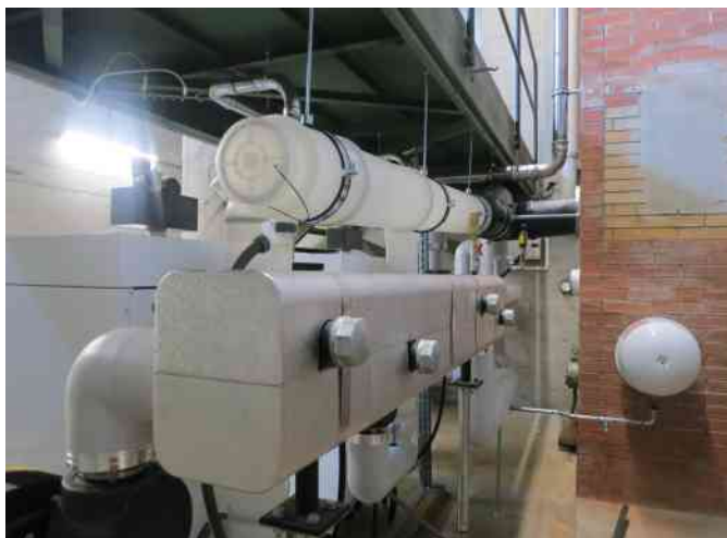
Verteilbalken und Abgasleitung. (Bilder: Weishaupt)
