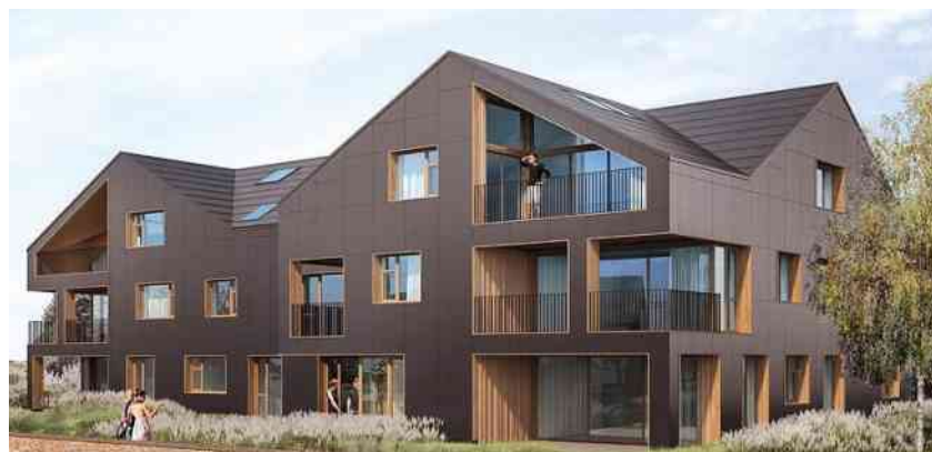
Energieautarkes MFH in Brütten ZH, ein Projekt der Umwelt Arena AG (vgl. HK-Gebäudetechnik 3/15 S. 36–39 und 8/16 S. 4–6).
