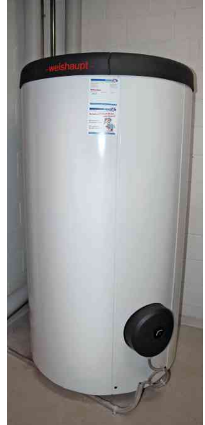
Der Trinkwasserspeicher WAC 300 (Weishaupt Aqua Comfort mit 300 Liter Inhalt) sorgt für einen hohen Warmwasserkomfort. Über einen Glattrohr-Wärmetauscher wird das Trinkwasser im Speicher erwärmt. Zusatzwärmequelle: Elektroeinsetzung.
