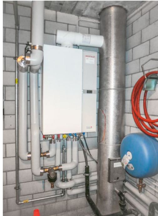
Platzsparende, wandhängende Gas-Brennwertanlage als Ausweichoption.
