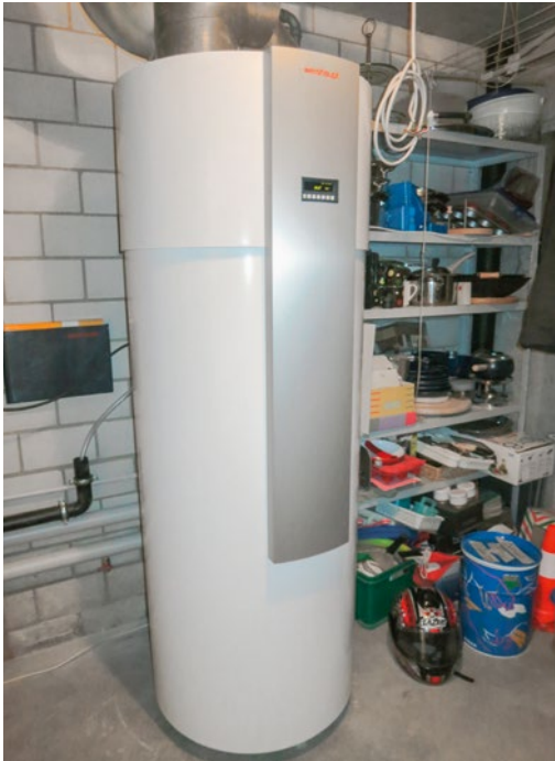
Trinkwasserwärmepumpe mit COP von 3,6.
