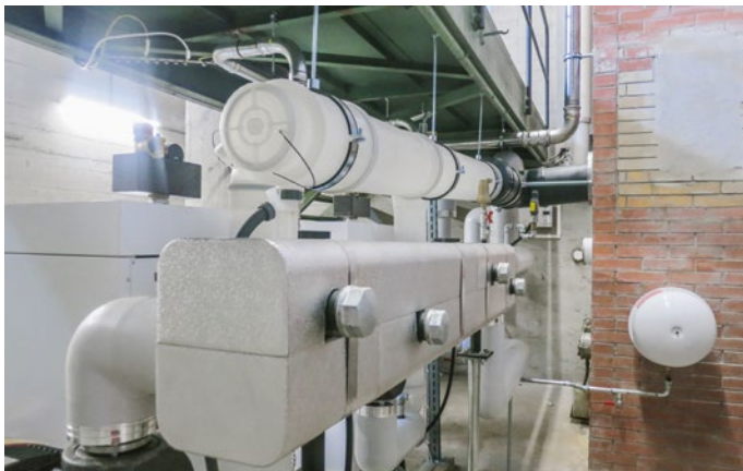
Verteilbalken und Abgasleitung.
