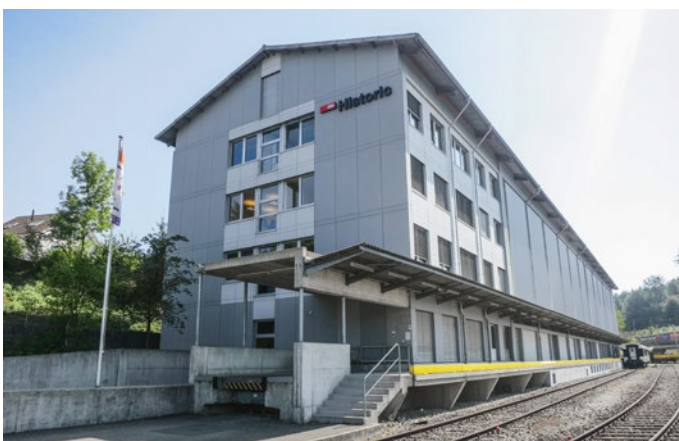
Das SBB-Historic-Gebäude mit Beständen von rund 3000 Laufmeter historischer Dokumente der SBB und ihrer Vorgängerbahnen, mit 450 000 Fotografien und Dias sowie rund 6500 historischen Film- und Videodokumenten brauchte ein neues Heizsystem.
